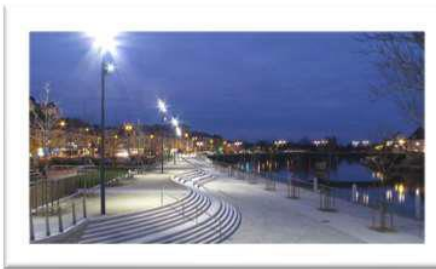
Éclairage public et voirie
