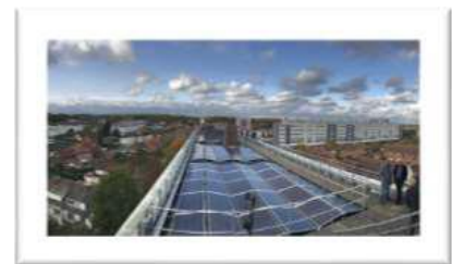
Solarisation des toitures
