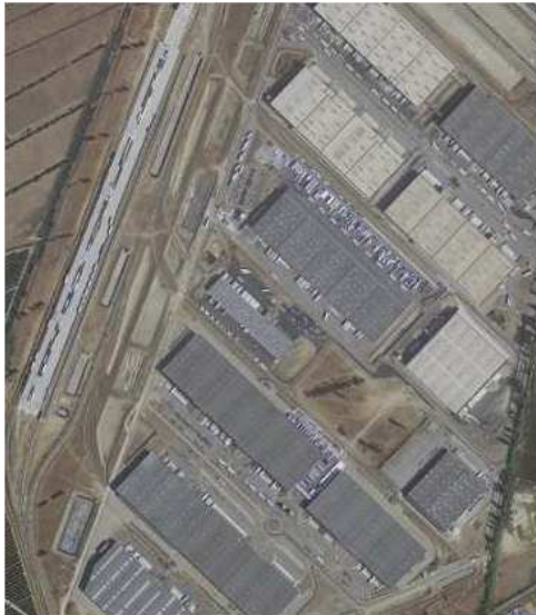
Vue aérienne d'une plateforme logistique
