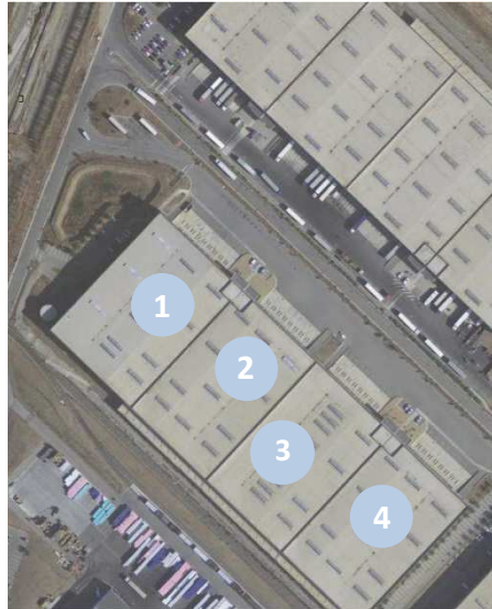
Un entrepôts constitué de 4 cellules de 6.000 m 2
